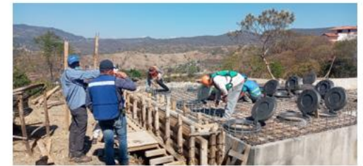
Imagen 2.1 DEWATS en construcción en la comunidad de Juliantla
