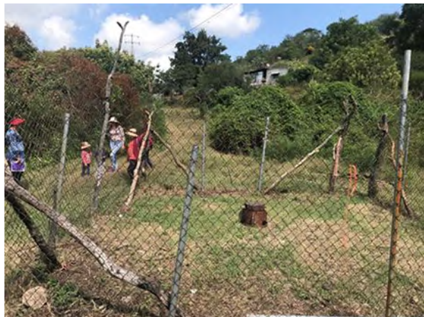
Fuente de abastecimiento: pozo perforado el año anterior
