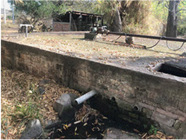
Caja de captación. Se observa la acumulación del agua en la obra de demasías
