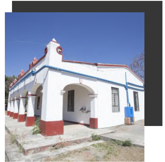
Sistema de captación de agua de lluvia (SCALL)
